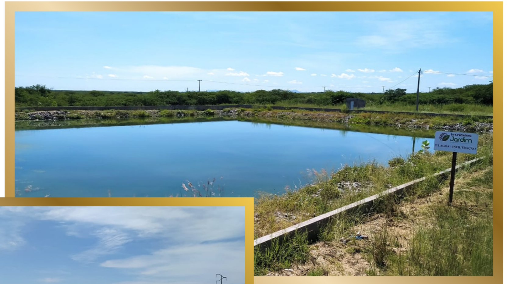
4ª Lagoa - Infiltração
